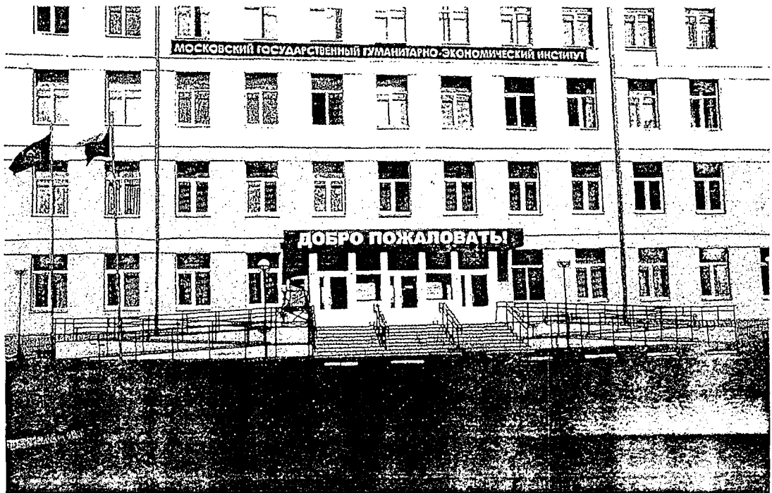
Фото 2. Вход в здание Московского государственного гуманитарно-экономического института (МГГЭИ)
